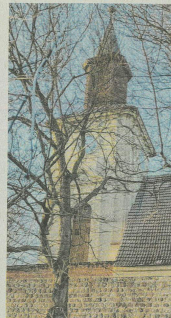
Die Klockower Kirche wurde zur Wende saniert.
