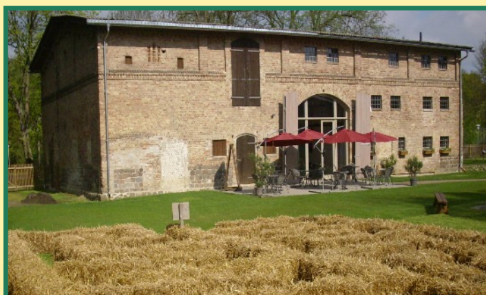
Speicher Malchow, der linke Teil soll ausgebaut werden
